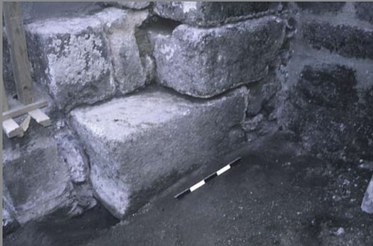
► blocs gallo-romains servant de fondation au mur gouttereau septentrional (cliché J. Roger, Inrap)
