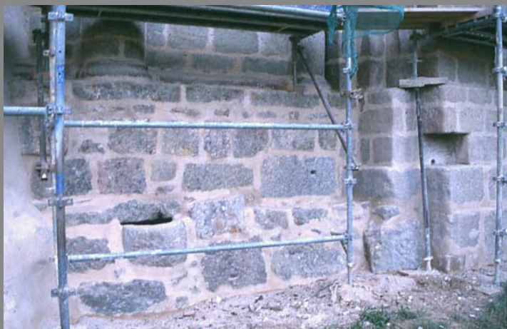
► vue des fondations du mur septentrional du chevet : on remarque une cuve de sarcophage réutilisée en bénitier (?) ainsi que des blocs gallo-romains portant un trou de louve (cliché J. Roger, Inrap).
